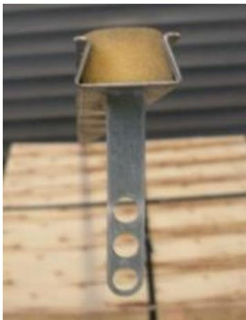
**L'ancoraggio per pareti (AS)** per giunti di malta a letto sottile viene agganciato alla guida di collegamento a parete integrata MAS 25/15 o alla guida di ancoraggio 28/15 e premuto nella malta del giunto della parete fino a riempire con malta i fori dell'ancoraggio per pareti.
