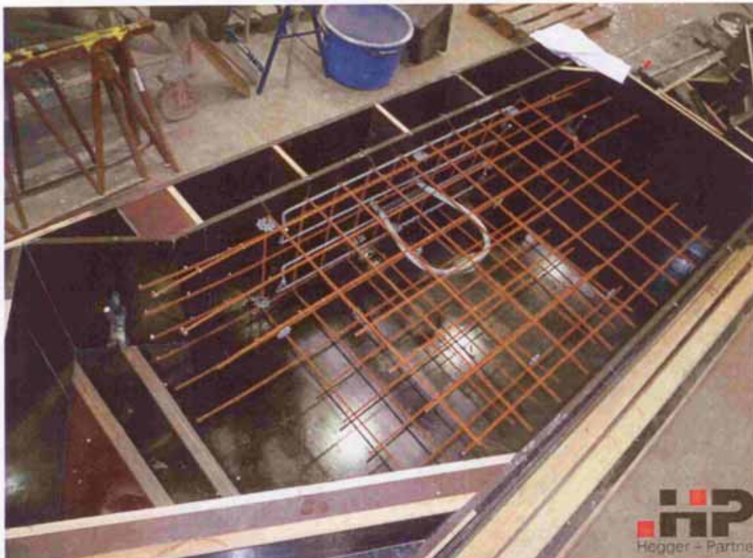
Bild 59 Versuchskörper mit Anker und Bewehrungskorb bei der Herstellung
