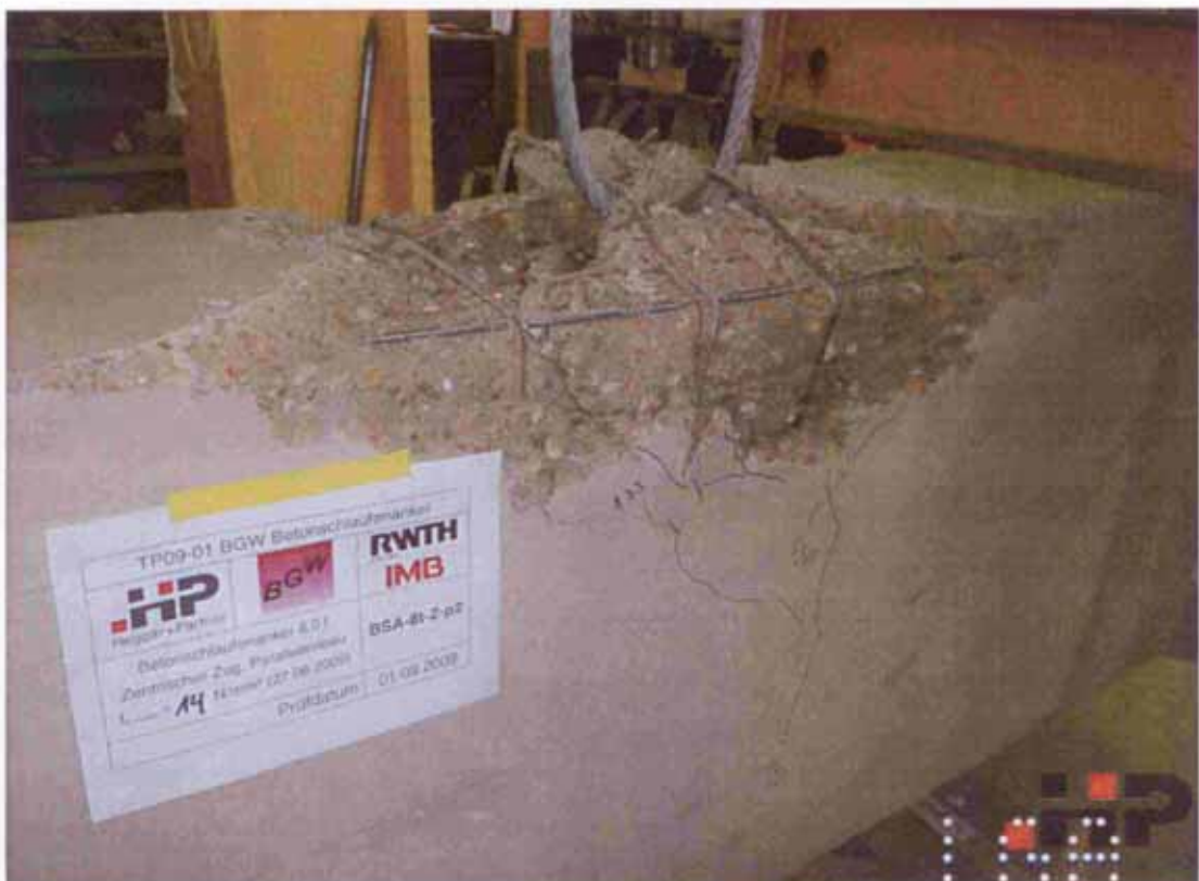
Bild 34 Betonausbruch und Herausziehen des Ankers
