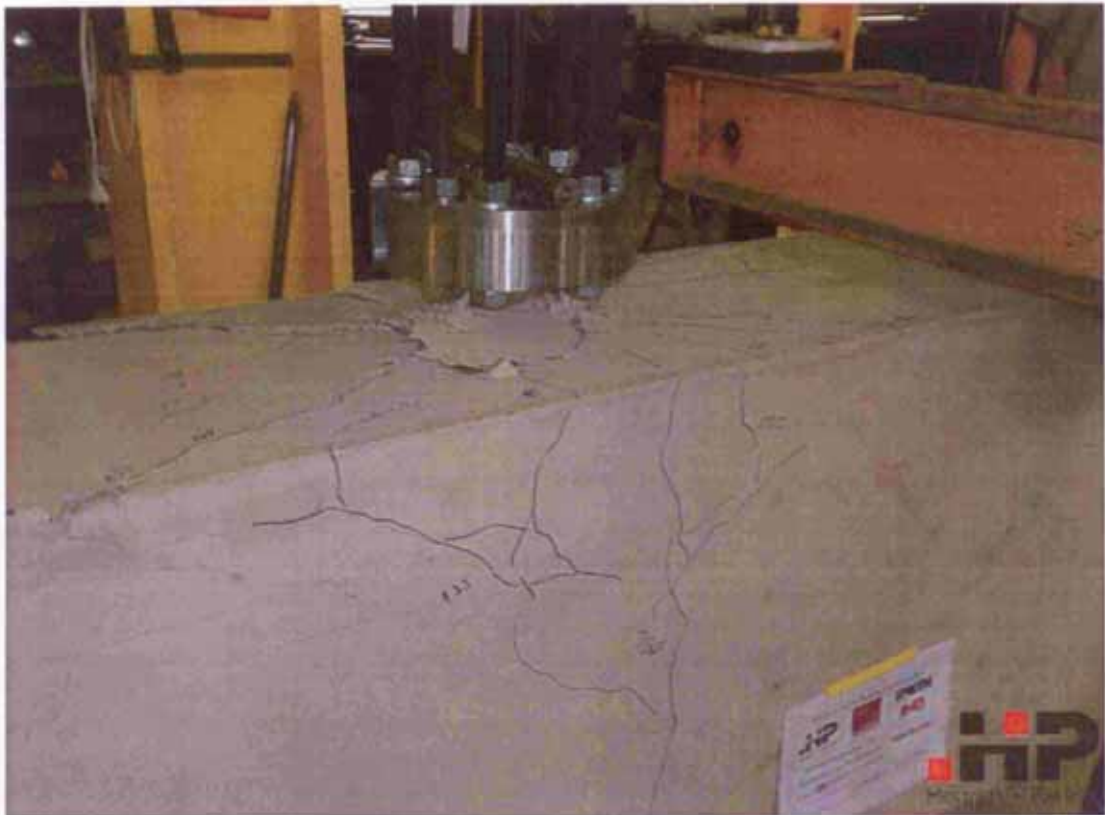
Bild 33 Fortschreitende Rissbildung und beginnender Betonausbruch
