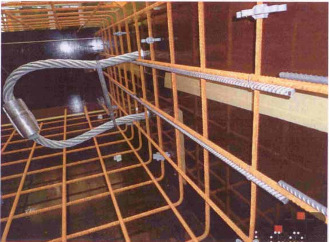
Bild 84 Innenaufnahme mit Auswechsel-Bewehrungsstäben
