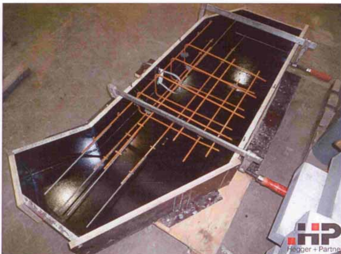
Bild 19 Versuchskörper mit Anker und Bewehrungskorb bei der Herstellung
