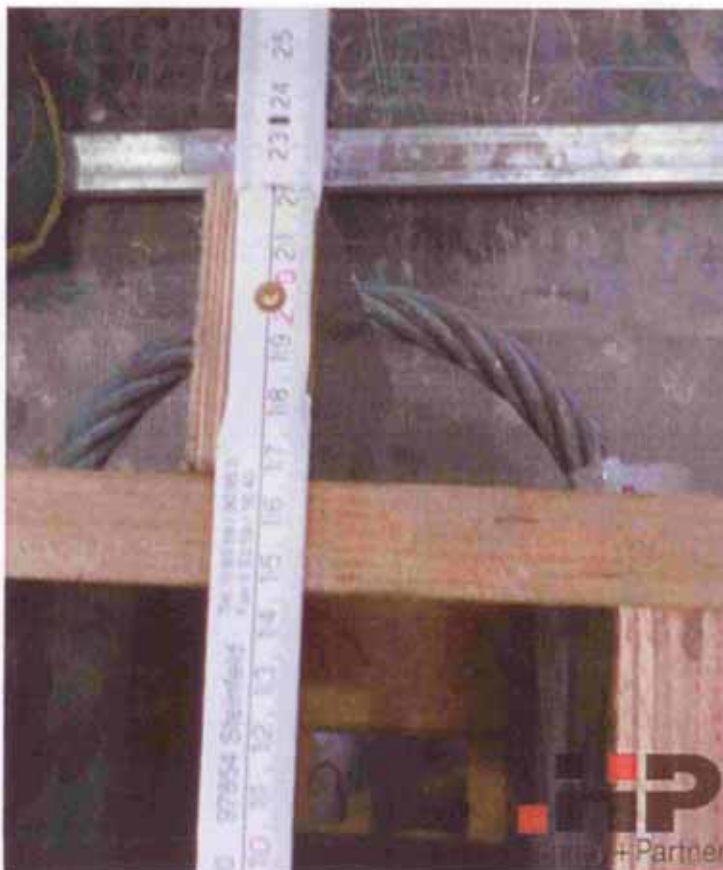
Bild 14 Betonschlaufenanker: Einbindetiefe 15cm
