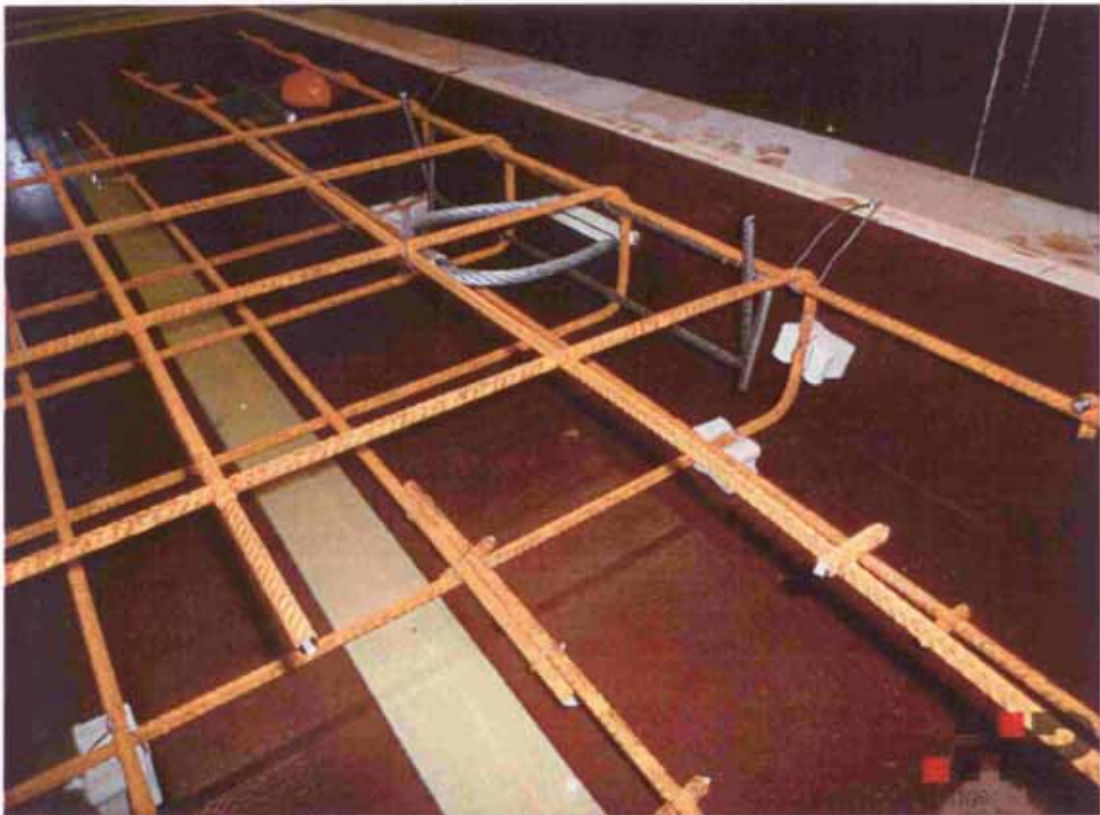
Bild 5 Versuchskörper mit Anker, Bewehrungskorb und Zulagebewehrung
