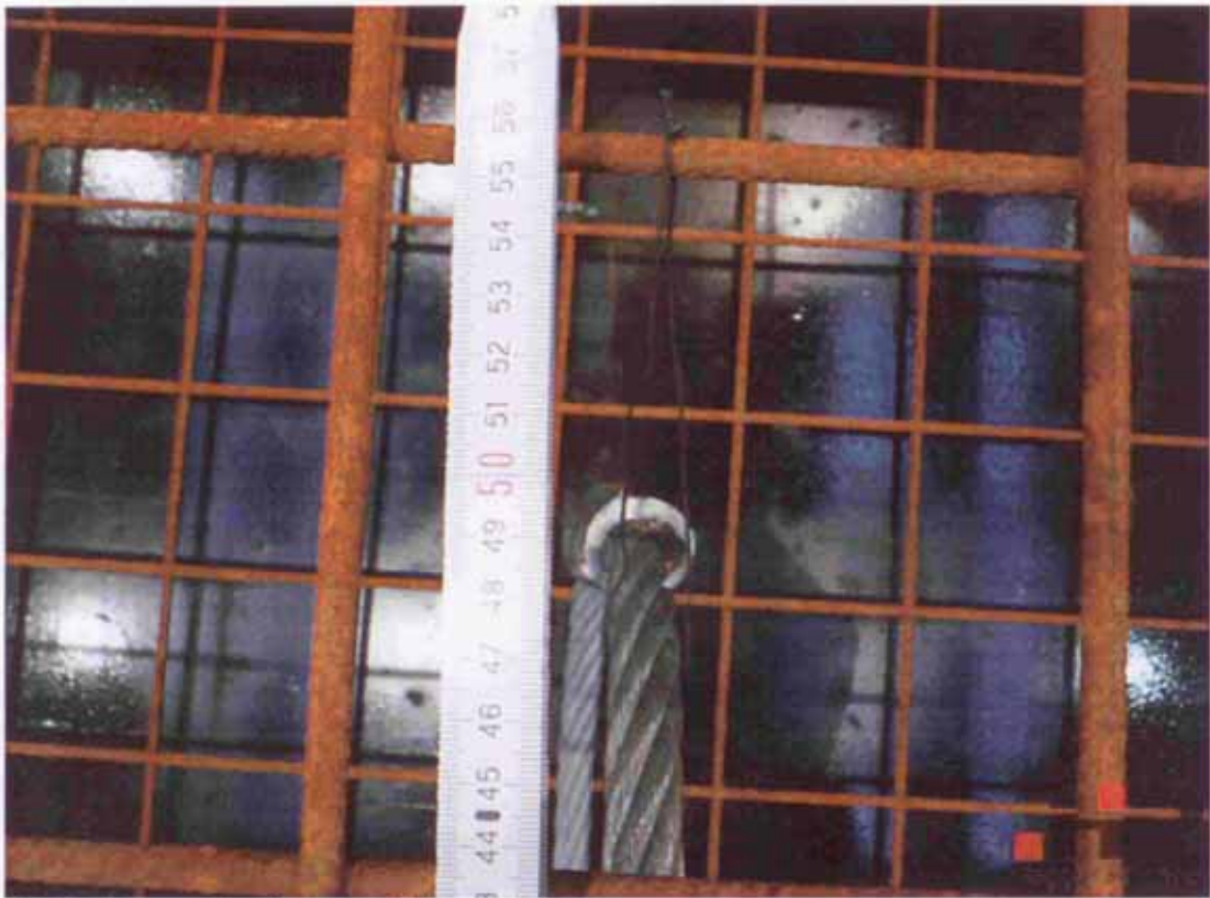
Bild 67 Betonschlaufenanker: Einbindetiefe 50cm
