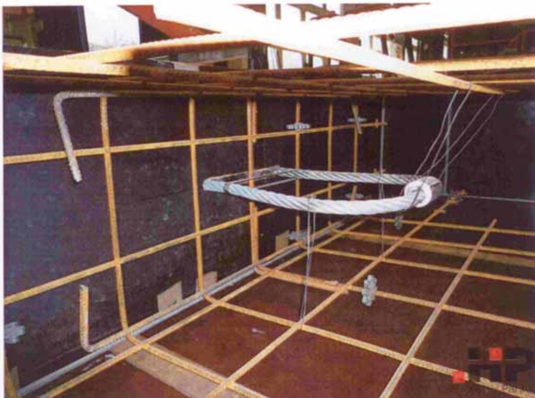
Bild 47 Innenaufnahme mit Zulagen- und Auswechsel-Bewehrungsstäben
