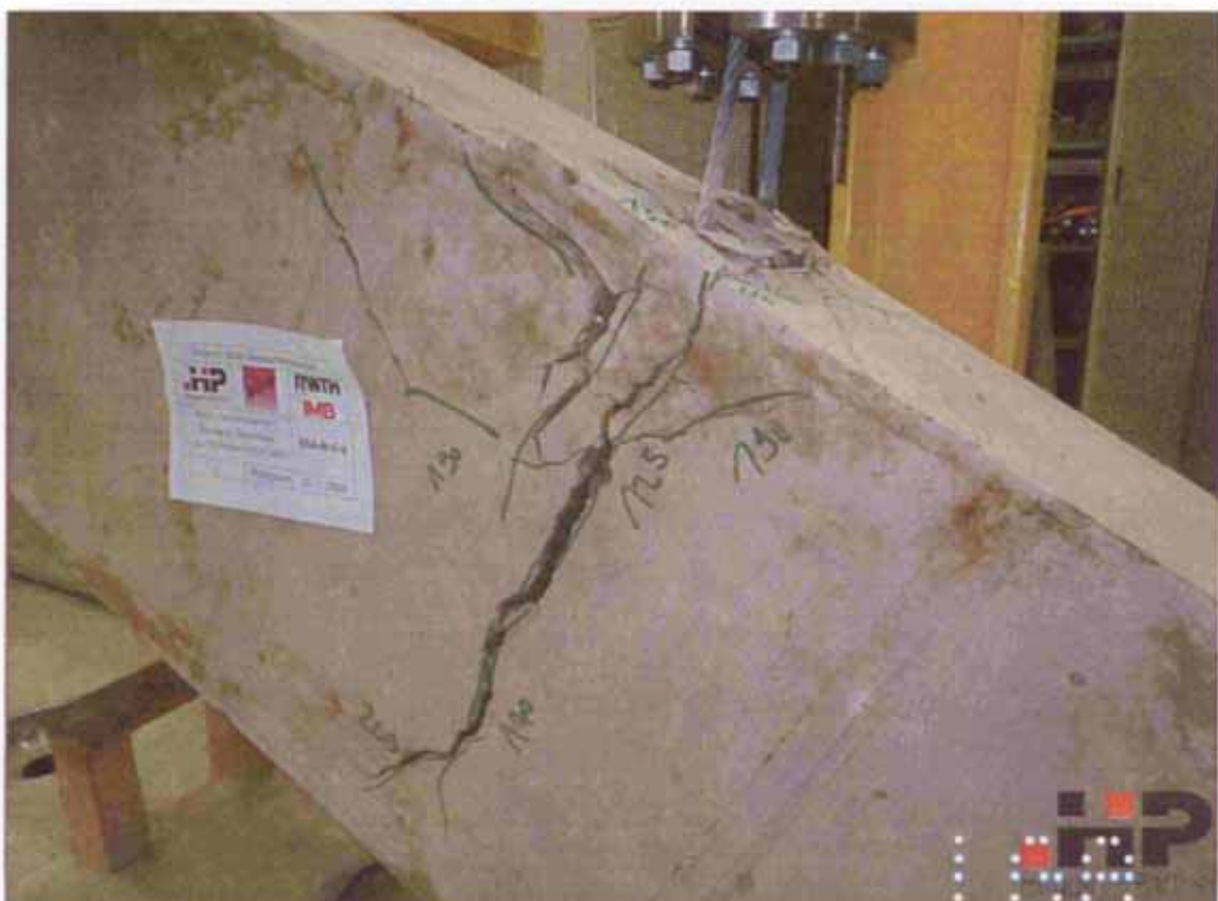
Bild 56 Fortgeschrittener, klaffender Biegeriss und oberseitige Betonabplatzungen
