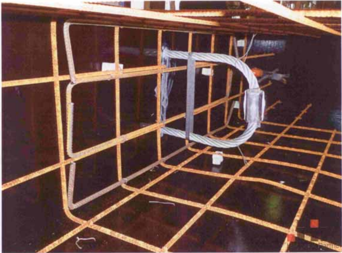
Bild 41 Innenaufnahme mit Auswechsel- bzw. Zulagebewehrungsstäben
