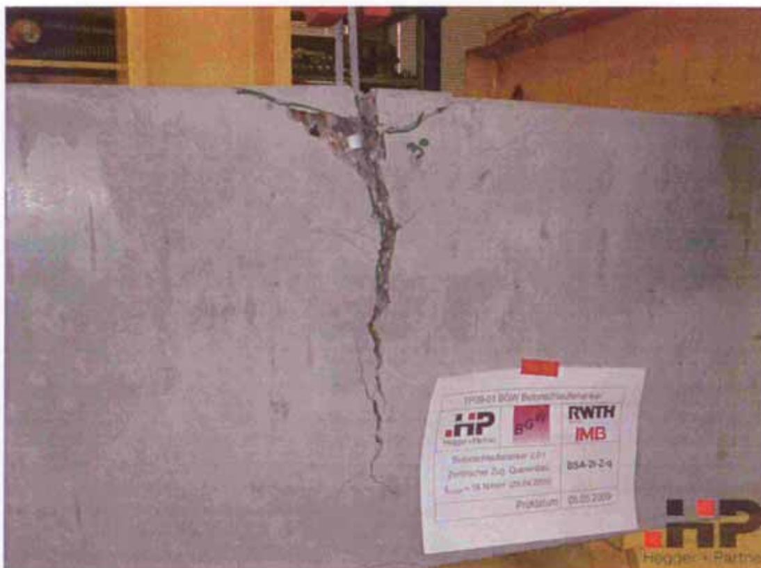
Bild 11 Biegeriss und lokale Betonabplatzungen
