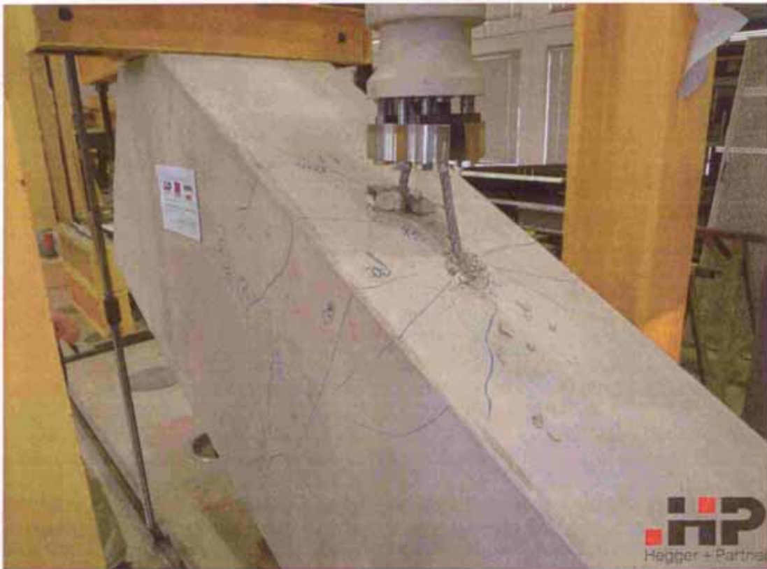
Bild 63 Fortgeschrittene Rissbildung und lokale Betonabplatzungen an den Ankerseilen
