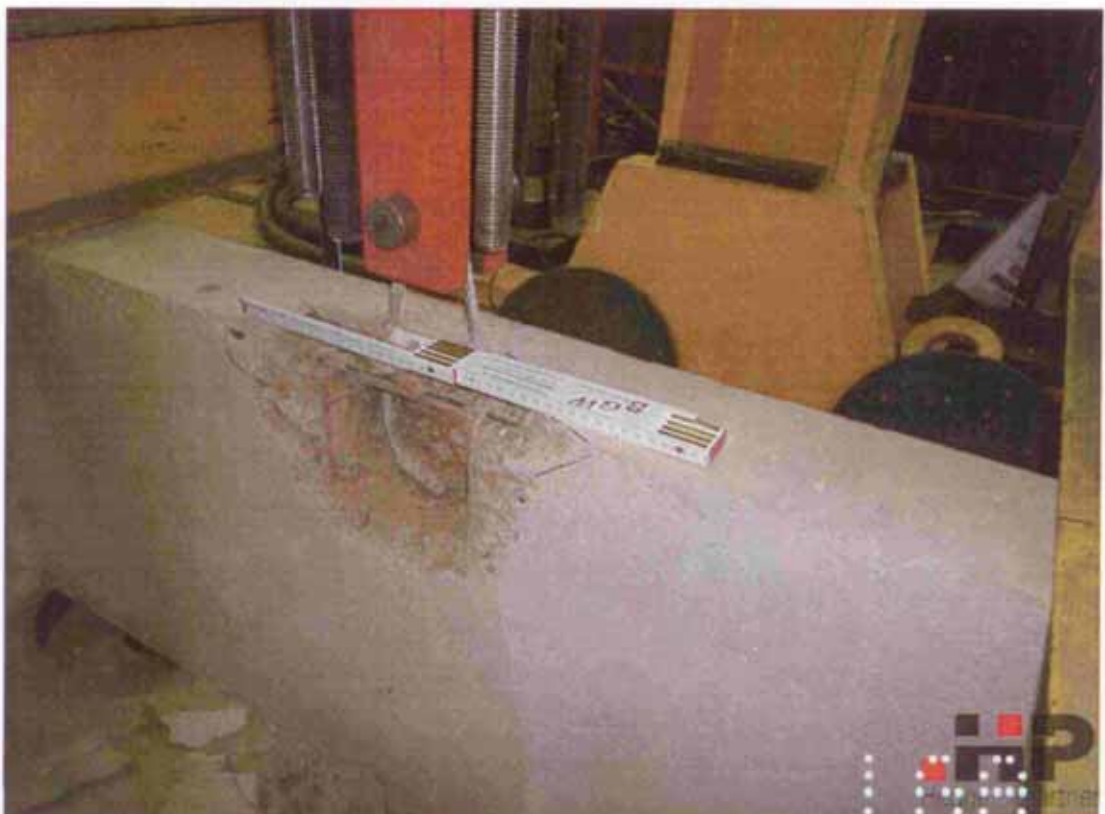
Bild 8 Betonausbruch und Herausziehen des Ankers
