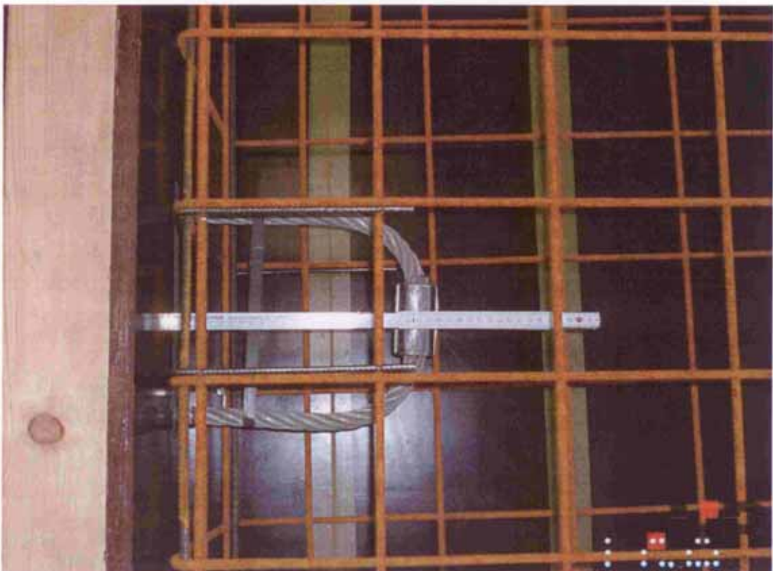
Bild 30 Betonschlaufenanker: Einbindetiefe 25cm
