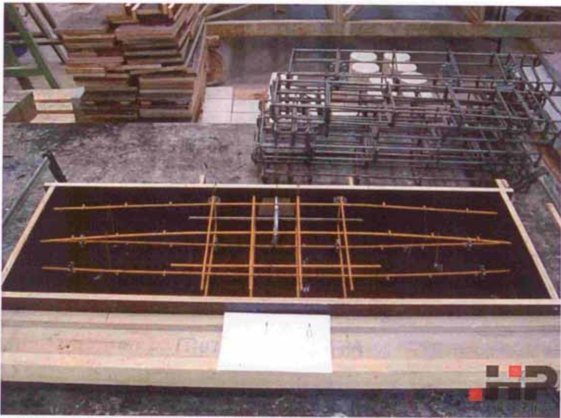
Bild 9 Versuchskörper mit Bewehrungskorb bei der Herstellung
