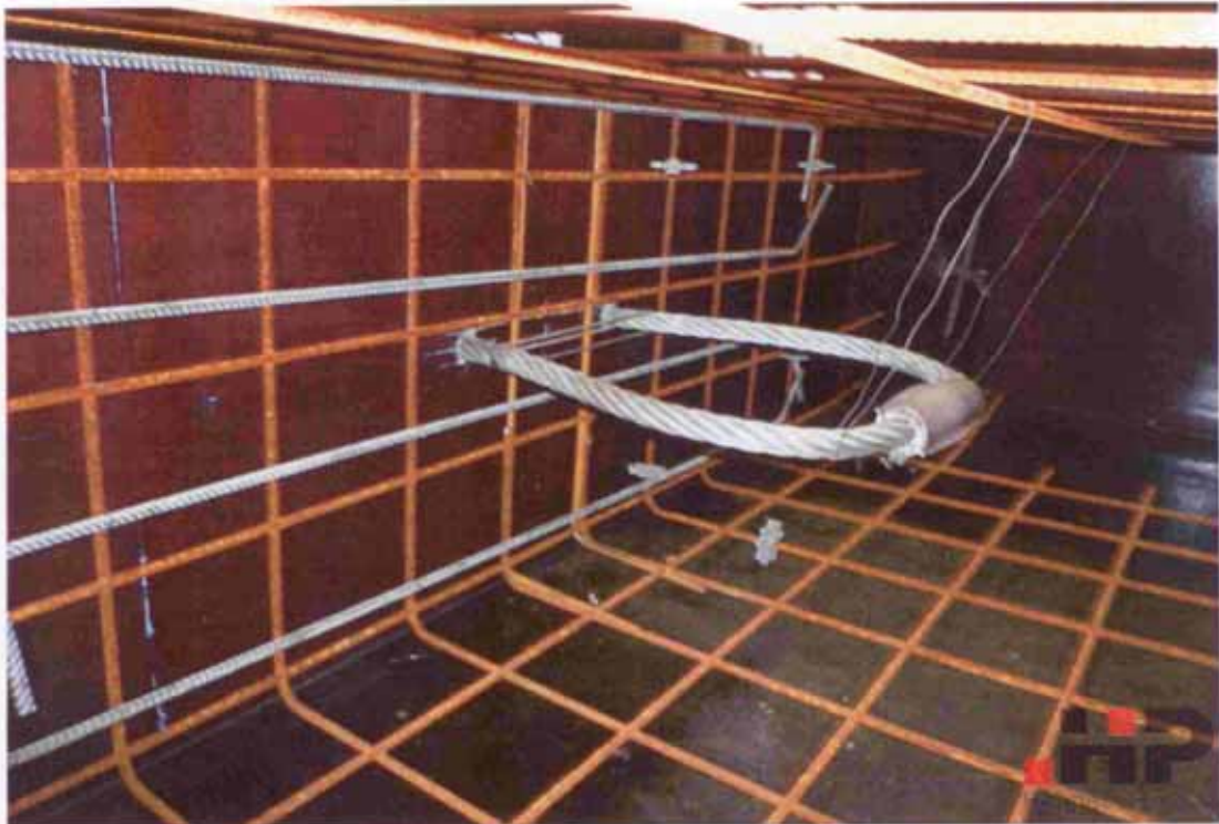
Bild 61 Innenaufnahme mit Zulagen- und Auswechsel-Bewehrungsstäben
