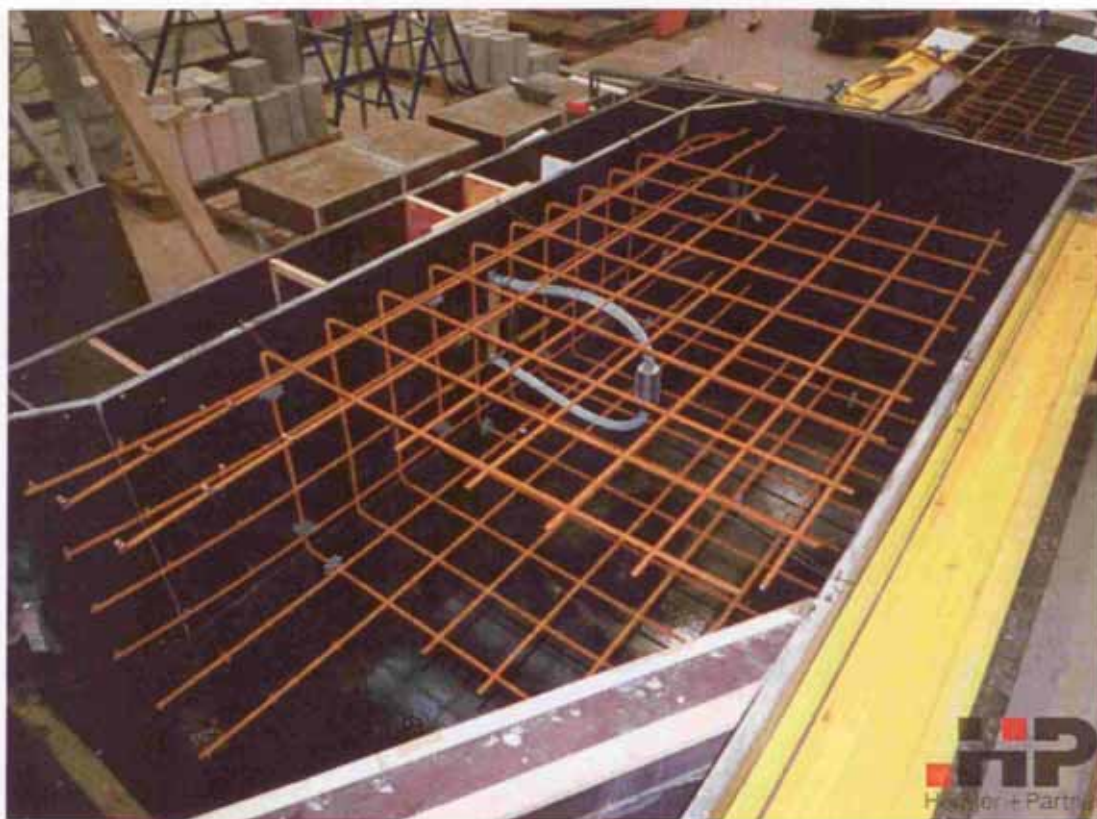
Bild 65 Versuchskörper mit Anker und Bewehrungskorb bei der Herstellung
