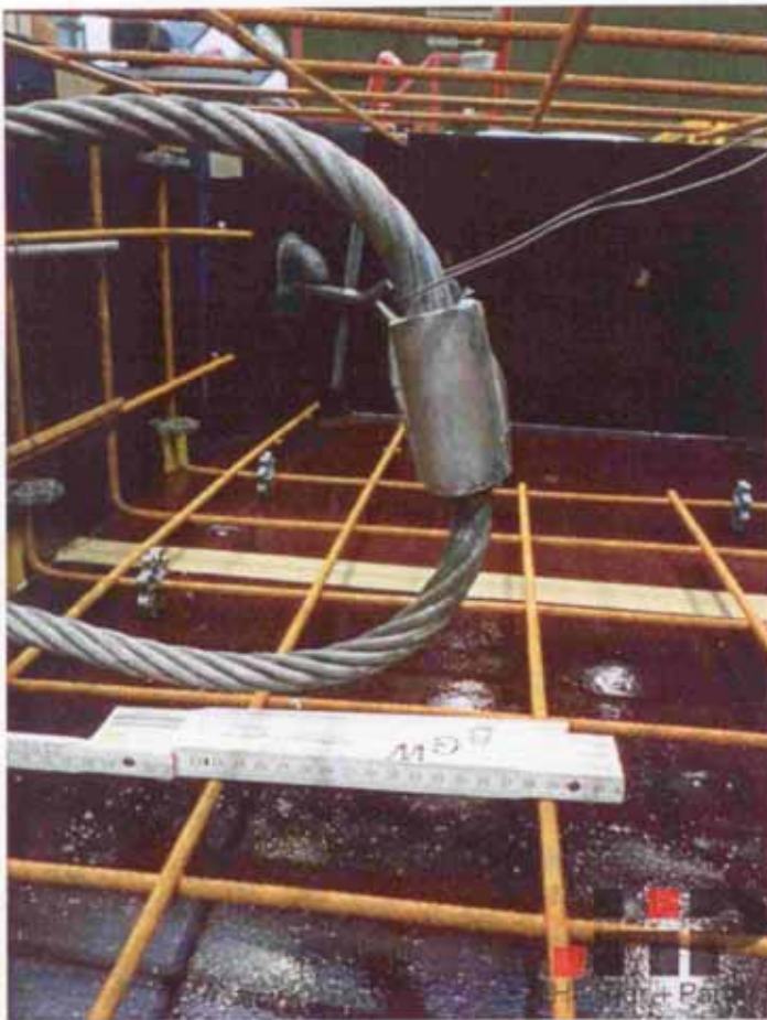
Bild 53 Betonschlaufenanker: Einbindetiefe 35cm
