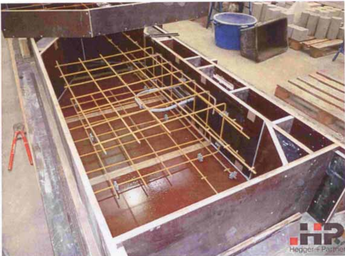
Bild 45 Versuchskörper mit Anker und Bewehrungskorb bei der Herstellung
