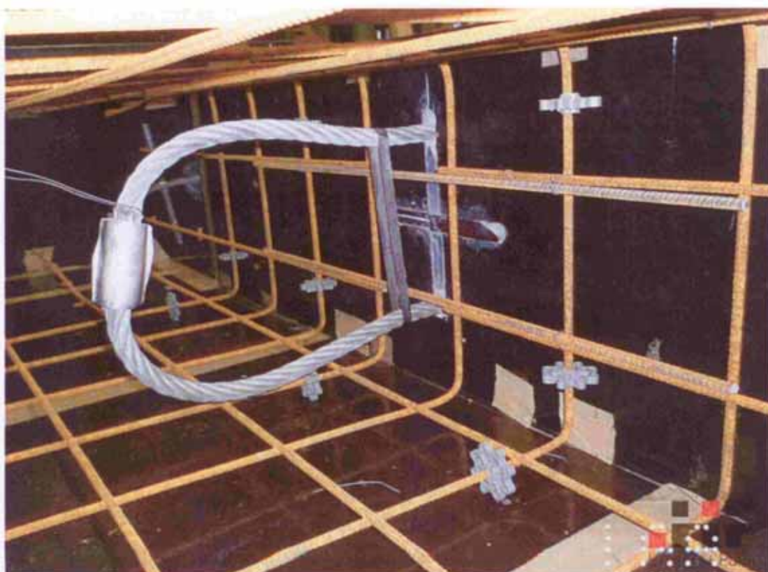
Bild 52 Innenaufnahme mit Auswechsel-Bewehrungsstäben
