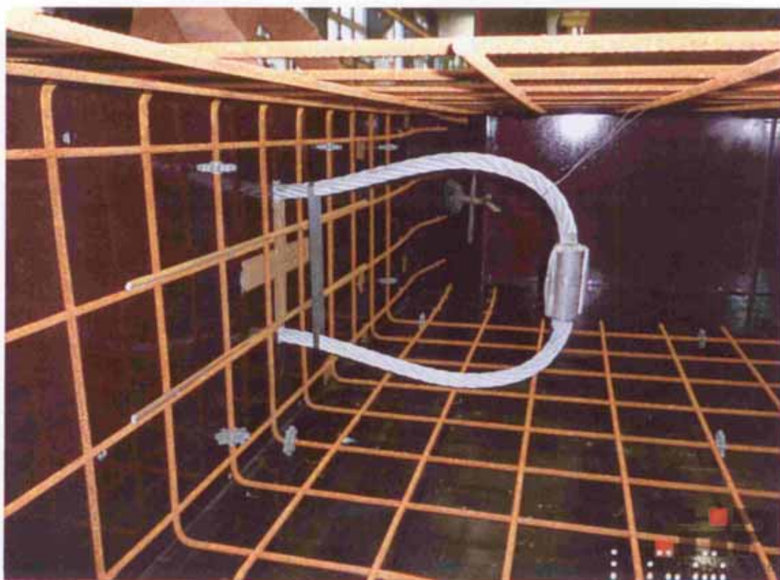
Bild 66 Innenaufnahme mit Auswechsel-Bewehrungsstäben
