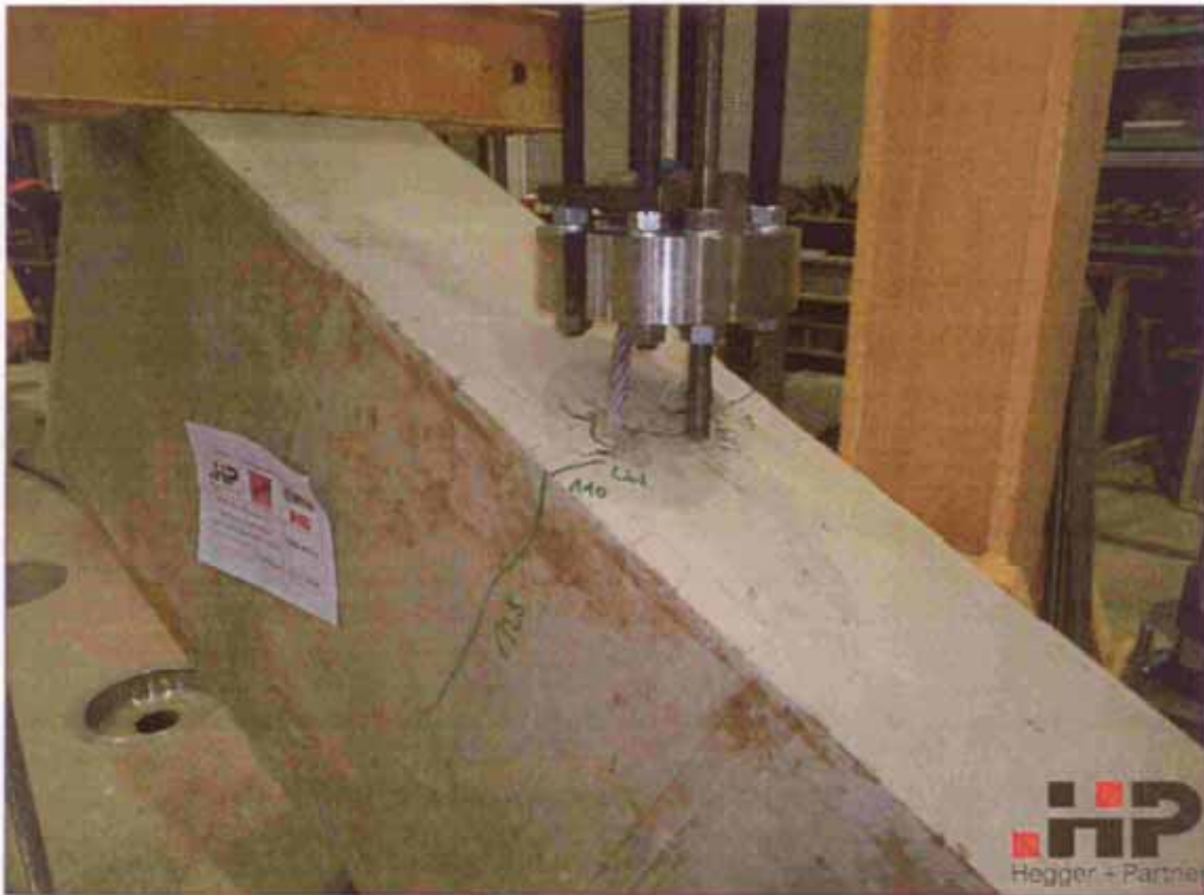
Bild 55 Beginnender Biegeriss und lokale Betonabplatzungen im Ankereinbindebereich
