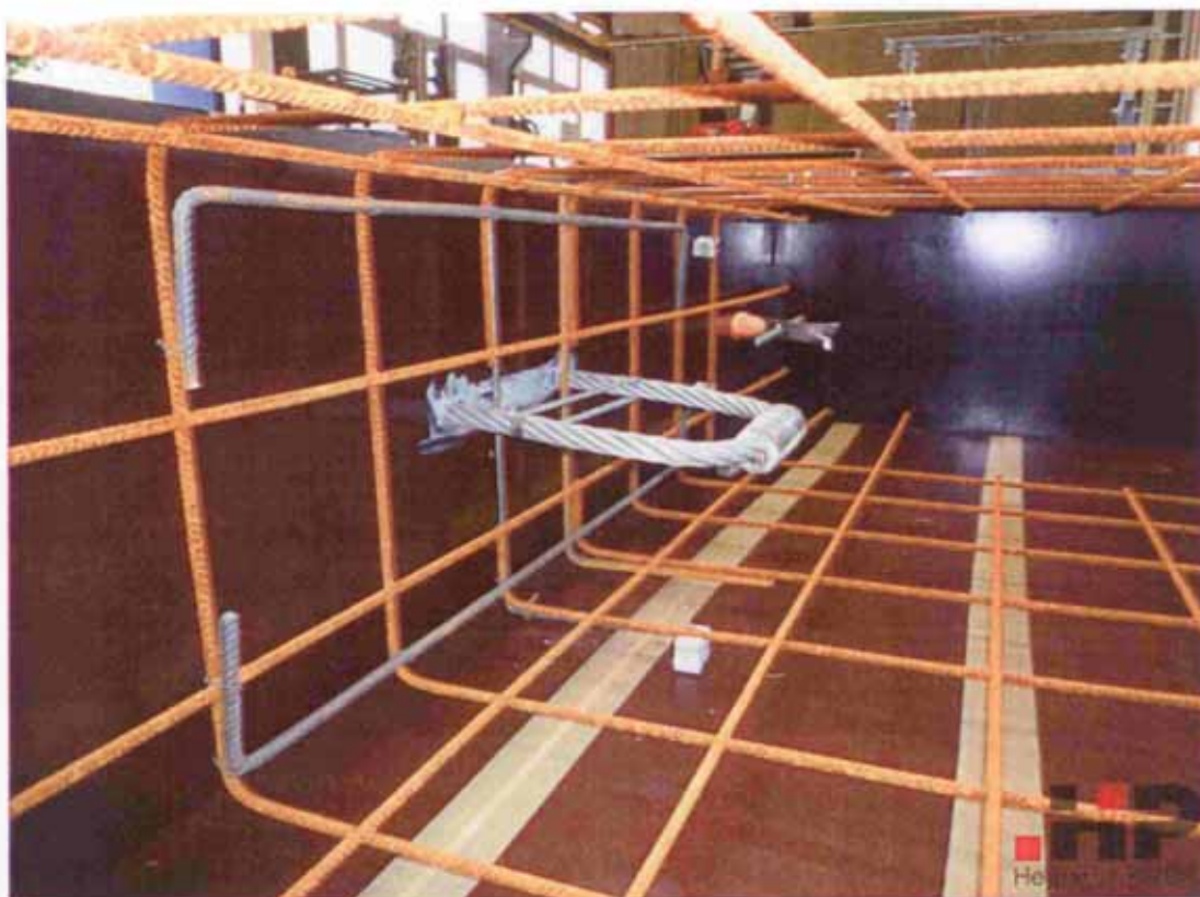
Bild 31 Innenaufnahme mit Auswechsel- und Zulagebewehrung sowie Transportanker (hinten)
