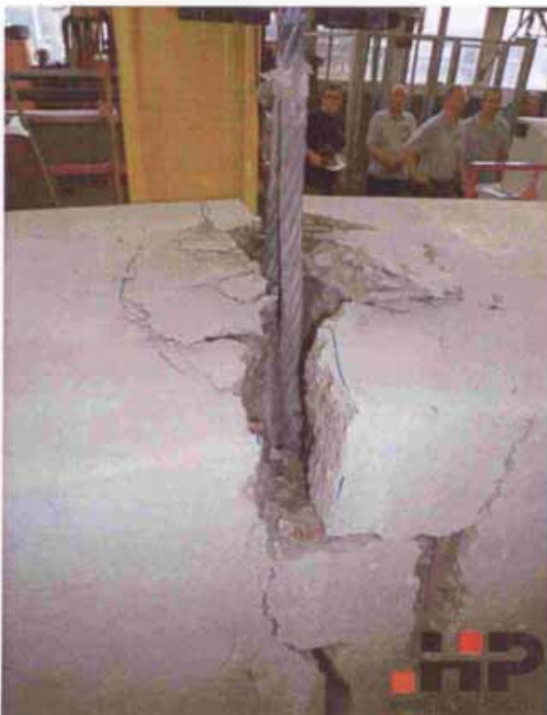
Bild 86 Betonausbruch und Herausziehen des Ankers
